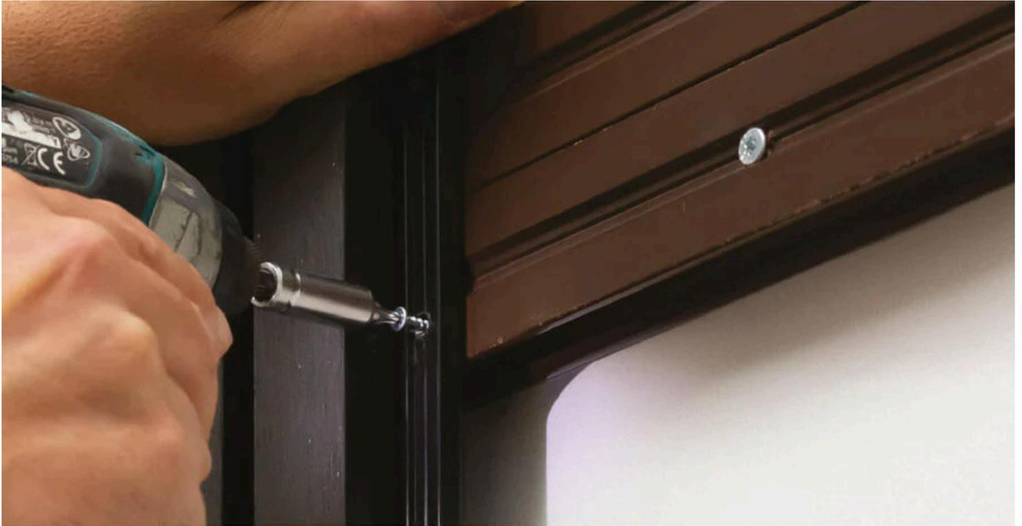
Dopo aver fissato il primo pannello quello successivo si collega tramite un sistema ad incastro con linguetta e scanalatura.
